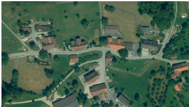
Abb. 19: Weilerartige Siedlungsstruktur im Ortsteil Hakab, Gartenbereiche zu Gunsten der Einbettung in die Landschaft, Google Earth, Januar 2020
